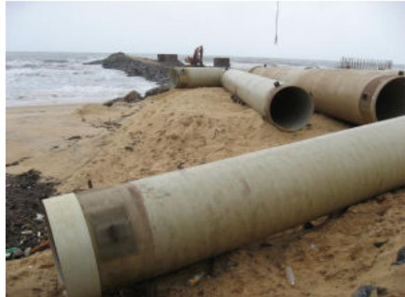
写真 4：導水管の敷設現場の様子
