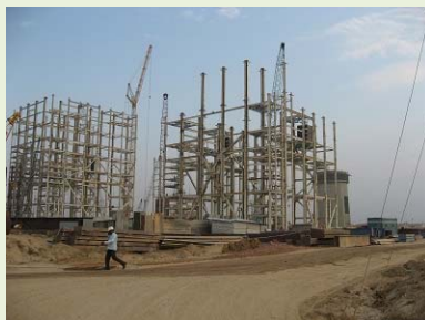
建設中のダリパリ石炭発電所
