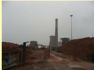
建設中のナガルジュナ火力発電所（インド）
